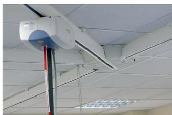
**Rotonda.** Con un cambio giratorio la grúa de techo puede cambiar de raíles en direcciones diferentes
